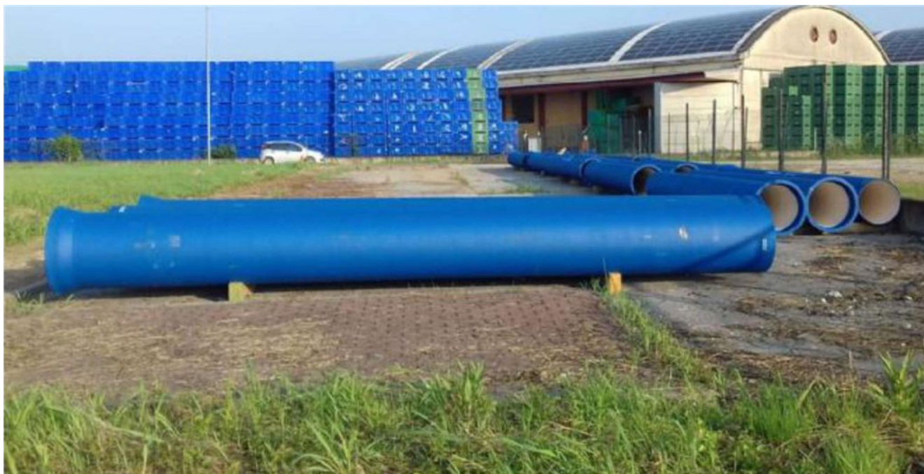
Tubi al cantiere di Belfiore all'inizio dei lavori per portare acqua pulita in una parte della zona rossa
